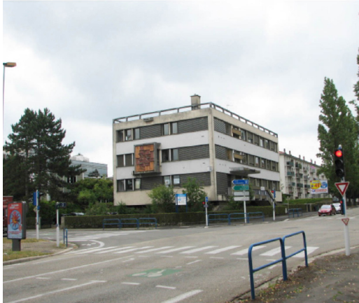
Bâtiment à réhabiliter
