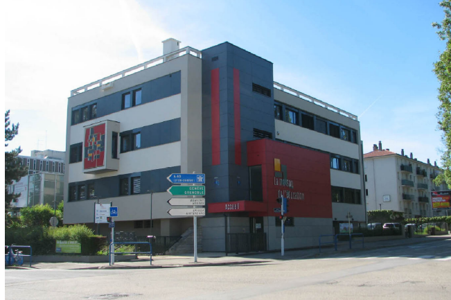
Façade d'angle- Boulevard Paul Valérie
