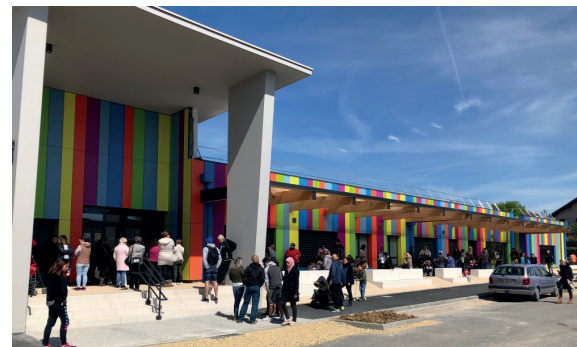
Photo de l'extension après travaux
