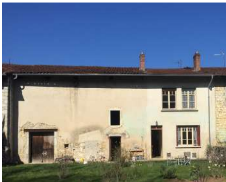
FAÇADE EST AVANT TRAVAUX - CÔTÉ JARDIN
