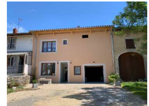
FAÇADE OUEST APRÈS TRAVAUX - CÔTÉ ROUTE
