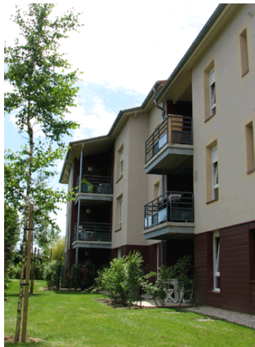
FAÇADE D'ANGLE - CÔTÉ JARDIN
