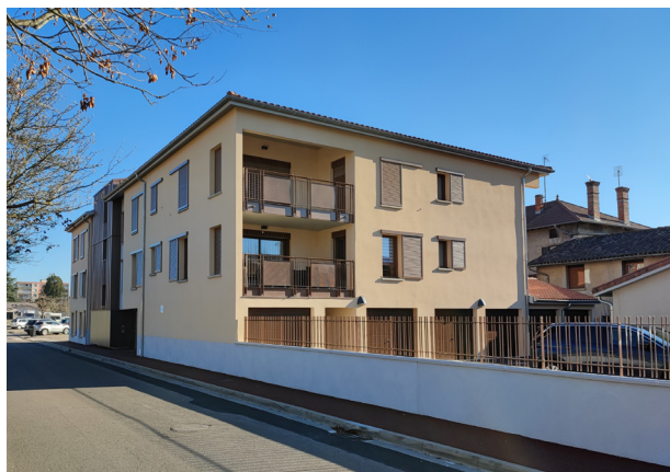
FAÇADE D'ANGLE DU SECOND IMMEUBLE AVENUE RAYMOND SARBACH
