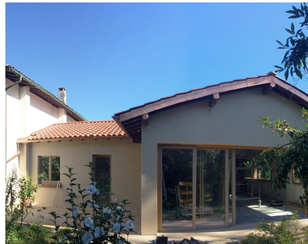
FAÇADE APRÈS TRAVAUX- CÔTÉ JARDIN
