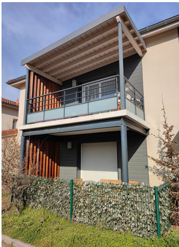
BALCON DE L'IMMEUBLE EN FOND DE PARCELLE
