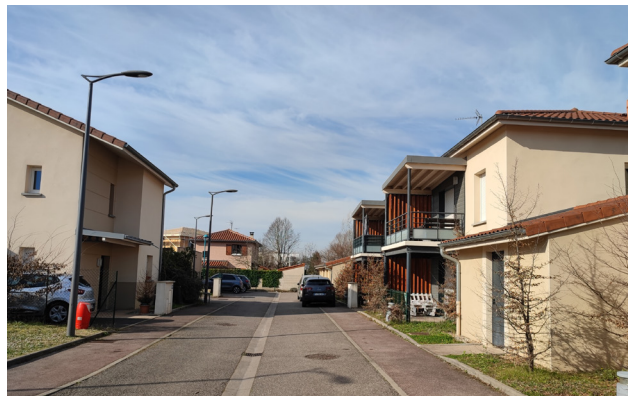
Traitement de la voirie en prologement des espaces privatifs
