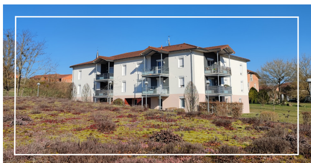
Vue de la réalisation depuis le toit végétalisé des garages
