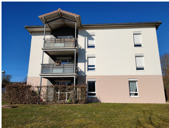
Vue des balcons métalliques en surplomb de la façade Sud
